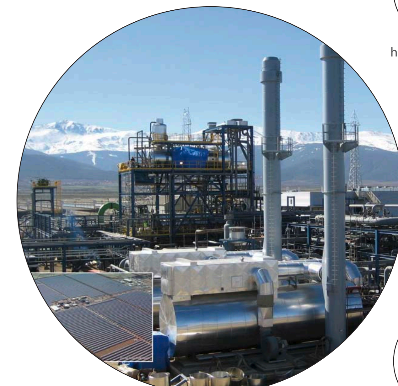
HTT Erhitzer (30 MW) mit Luftvorwärmer zur optimalen Energieausnutzung in der Sierra Nevada
